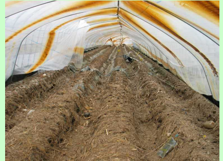
津波の被害を受けたパイプハウス
